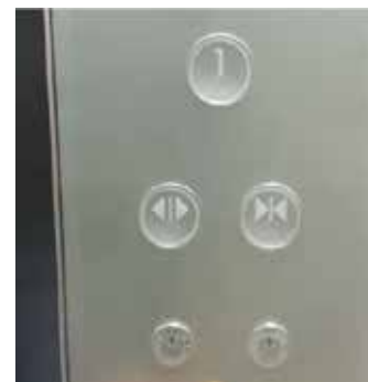
エレベーターボタン
